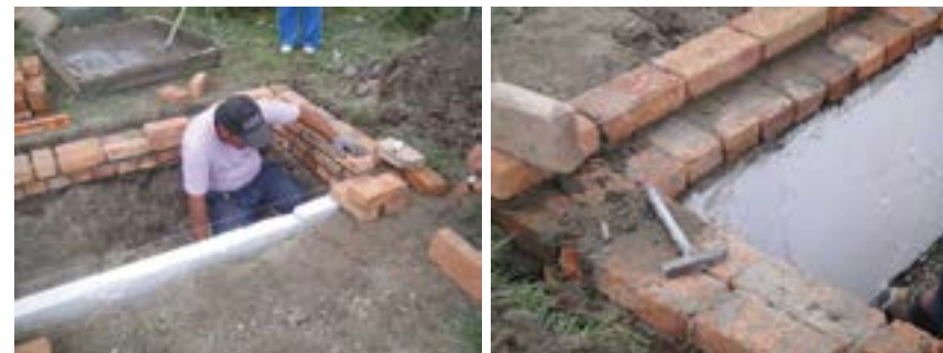
Зураг 6. Урд ханын хөөсөнцөр дулаалга дээр өрлөг хийгдсэн байдал
